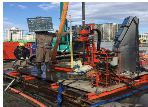
図-5 試験施工状況
