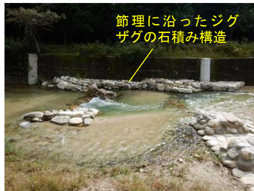
写真-2 施工後の状況(2016年3月完成、同年10月調査、)
