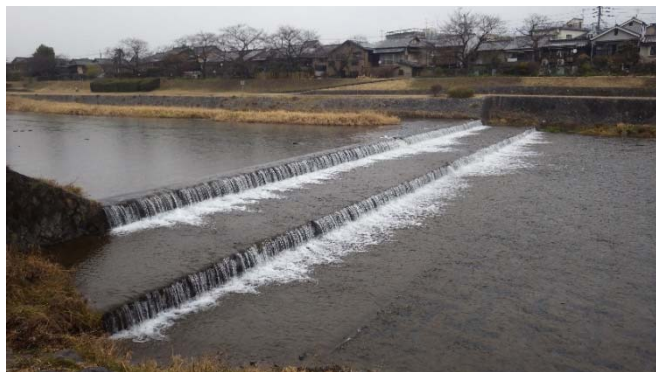
写真1 鴨川と高野川との合流点より上流にある床固工
