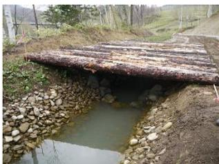
写真1 巨礫, 丸太設置状況
