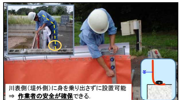
図-1 膜式水防資機材の安全の工夫
