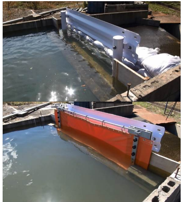
図-2 水槽実験の状況（土嚢積みと膜式水防資機材）
