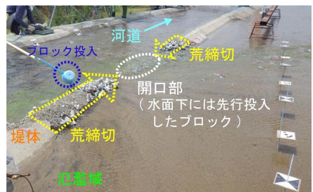
図-3 荒締切実験の状況（ケース3）
