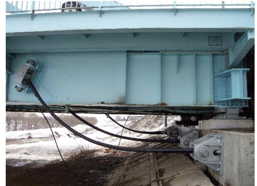
写真-1 落橋防止構造の例
