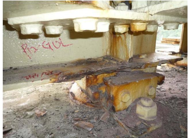
写真-1 端支点部の腐食状況
