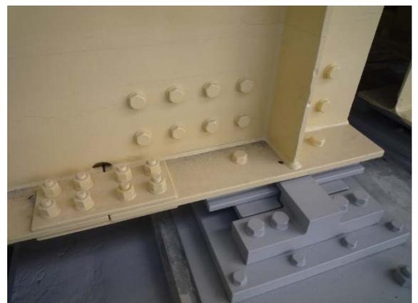
写真-3 下フランジ取替後の状況
