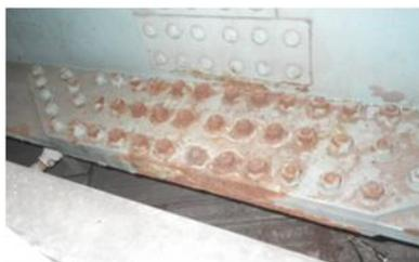
図-1 添接板の腐食
