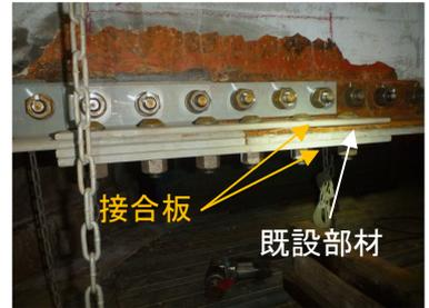
写真-1 腐食鋼橋の補修の例
