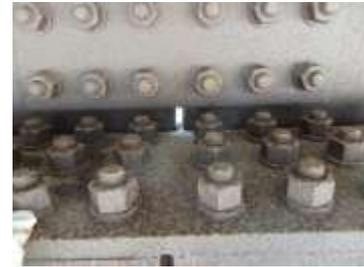
写真-1 高力ボルトを用いた摩擦接合
