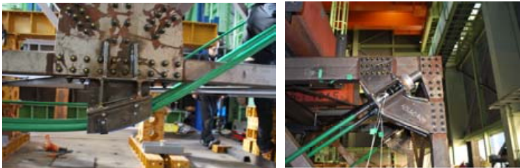
(a) 下弦材格点部 (b) 上弦材格点部 写真2 ケーブル定着構造
