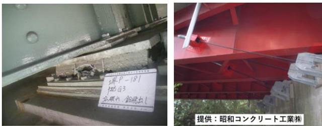
図1. 劣化ゴム支承<sup>1)</sup>(左)とケーブル(右)
