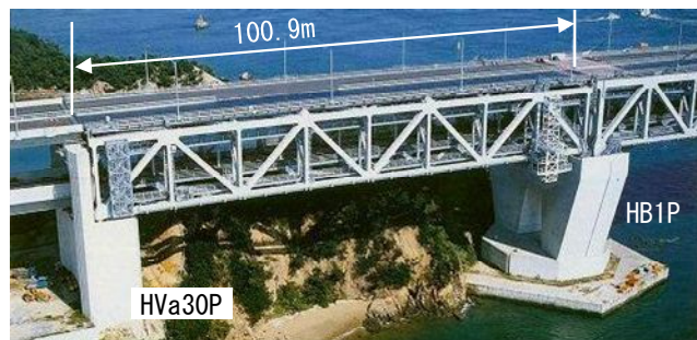
写真-2 櫃石島高架橋トラス部
