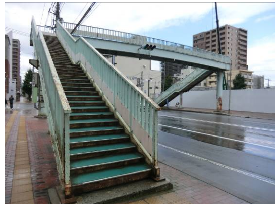
図-1 実験対象橋梁
