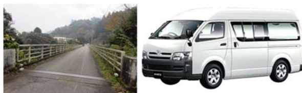
図4 計測を行った橋梁および計測車両
