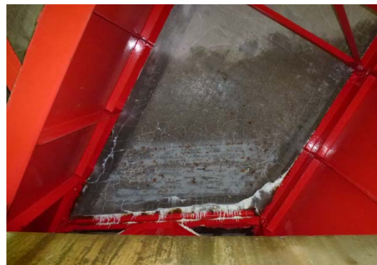
写真-2 ジョイント付近の床版
