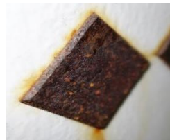
写真-2 河野大橋海側鋼板
