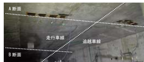
a) 桁内全景
