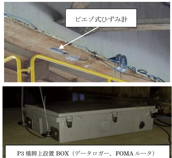
写真-1 機器設置写真
