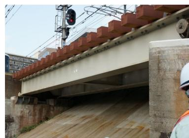
図 2 架設後の桁の外観<sup>2)</sup>
