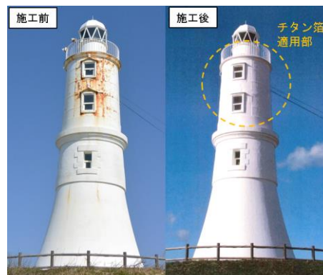
写真3 灯台上部構造へのチタン箔シート適用
