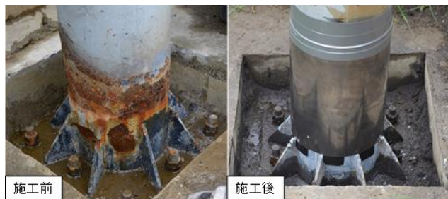
写真2 標識柱地際部へのチタン箔シート適用
