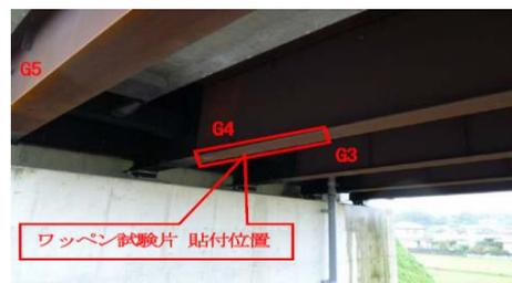
写真 1 ワッペン試験片設置位置
