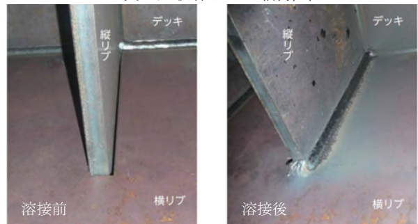
図2 試験体の溶接部の様子
