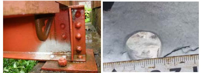
写真-1 対象支点部
