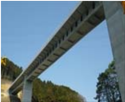
写真－1 橋梁全景
