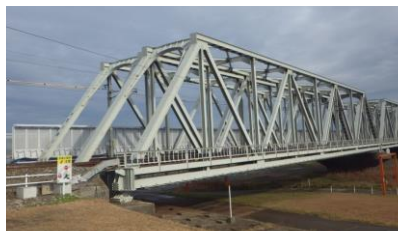
写真-3 対象橋梁
