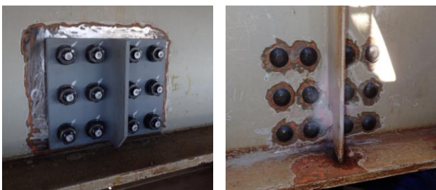
写真-4 施工後（桁外側） 写真-5 施工後（桁内側）
