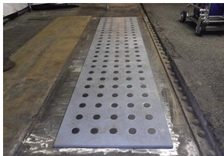
写真-5 当て板設置後の状況
