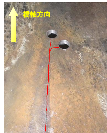
図-3 き裂とストップホール設置状況
