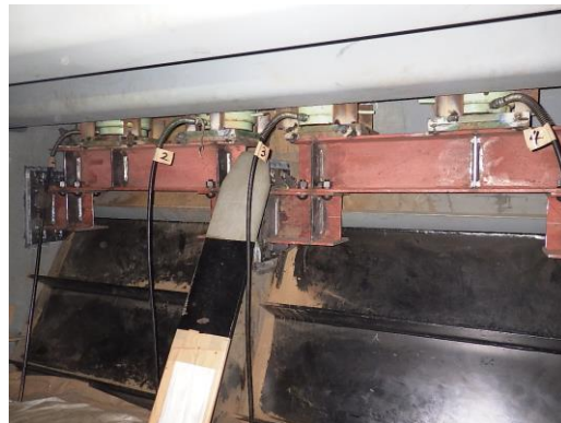
写真-2 損傷部周辺の仮受状況
