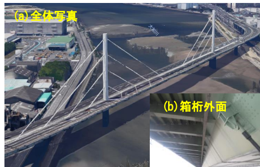
図-1 3 径間連続鋼斜張橋
