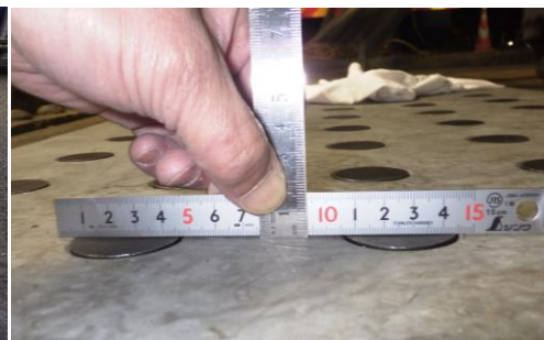
写真-6 ボルト頭部の設置状況
