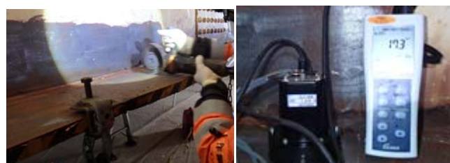
写真-1 素地調整の状況と塩分測定の状況
