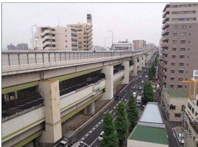
図-2 着工前の写真
