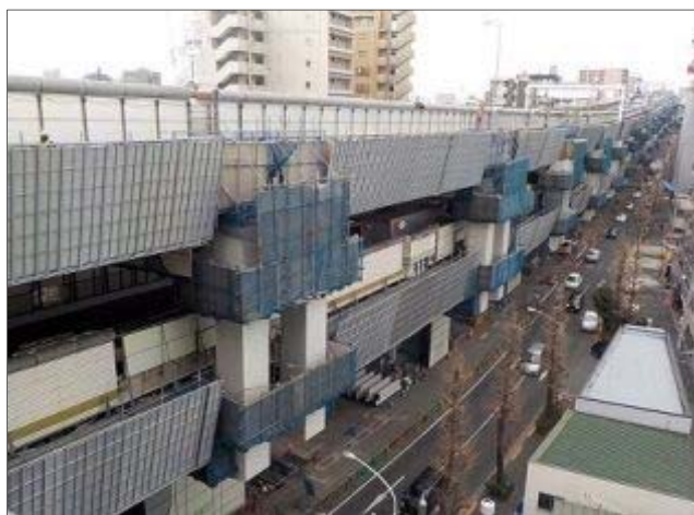
図-3 建設途中の写真
