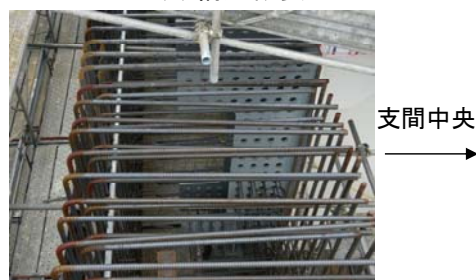
(b) 補強筋施工状況
