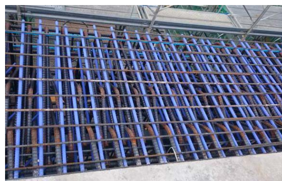
写真-2 剛結部天端配筋状況
