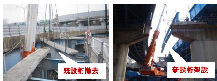
写真-1 G4 桁の撤去・架設状況
