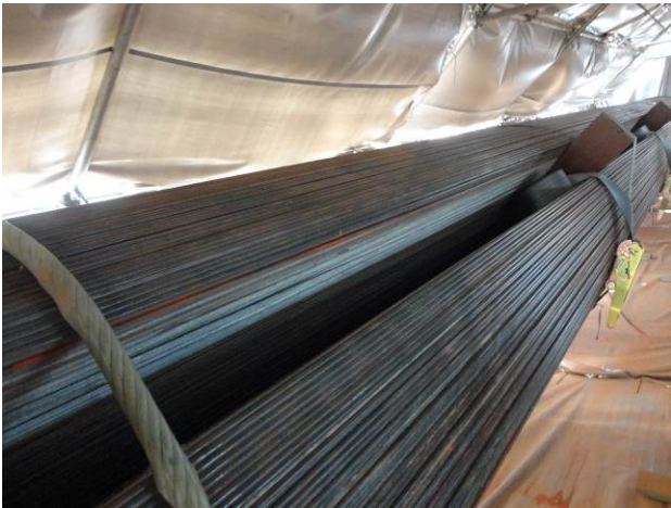
図2 主ケーブル開放状況
