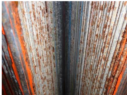
図 4 主ケーブル下面開放状況
