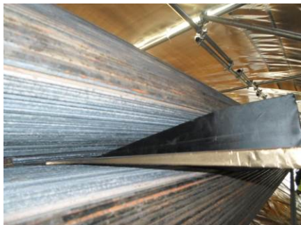
図 3 主ケーブル側面開放状況
