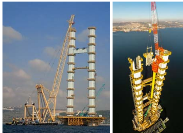
写真-3 主塔架設状況
