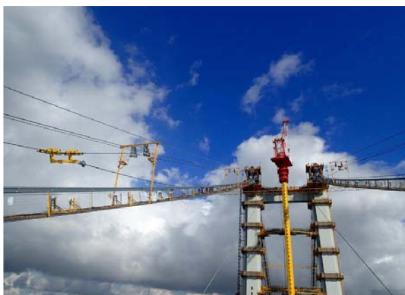
写真-4 PPWS 引出し状況
