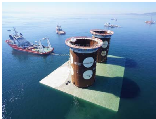
写真-1 ケーソン沈設状況
