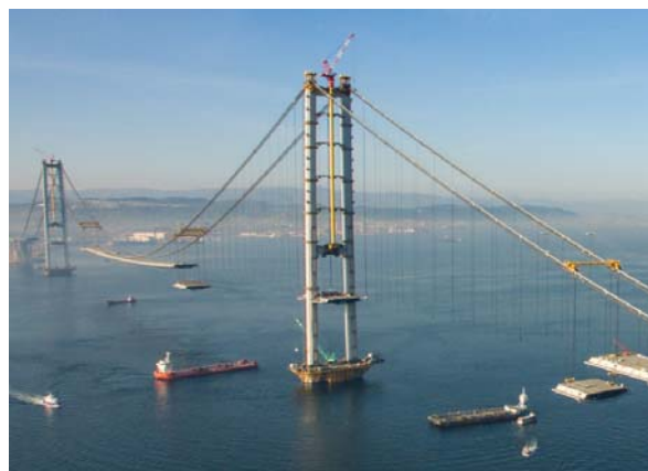
写真-5 補剛桁 LD 架設状況
