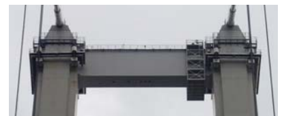
写真-2 水平梁外面作業車
