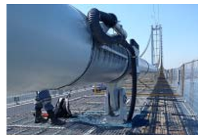
写真-8 ケーブル送気カバー
