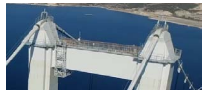
写真-5 塔頂外面管理路
