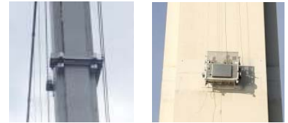
写真-1 塔柱外面作業車
