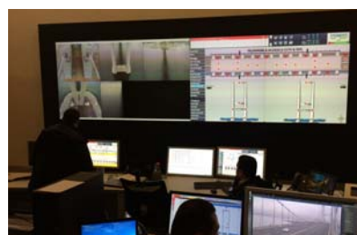
写真-10 コントロールセンター
