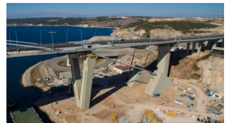
写真-1 北側アンカレッジ
