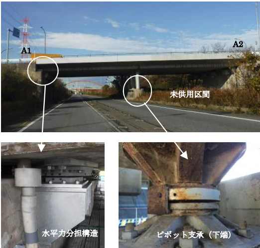
写真-1 対象橋梁
