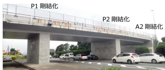
図-5 東原橋の耐震補強後の状況
