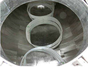
写真-2 制振装置設置の様子
