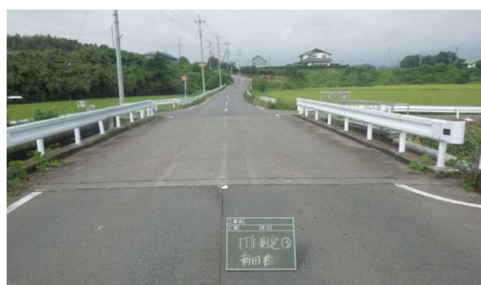
図3 調査対象実橋(橋長 13.5m 幅員 7m)
