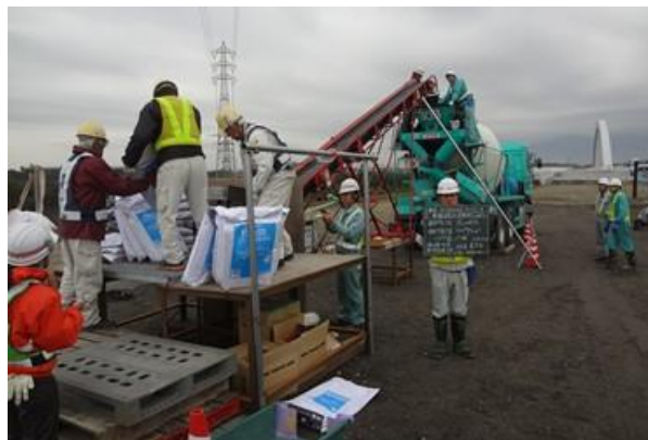
写真-4 有機繊維の投入状況
