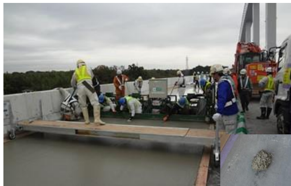
写真-5 HFRC の打込み状況(右下:ファイバーボール)
