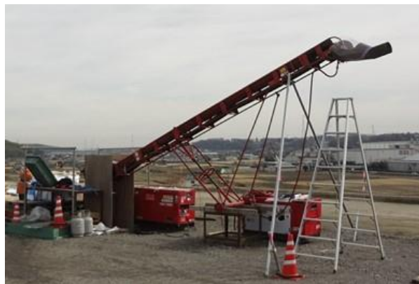
写真-3 有機繊維の投入装置
