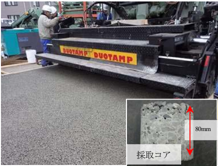
写真-1 ハイブリッド Con 施工状況
