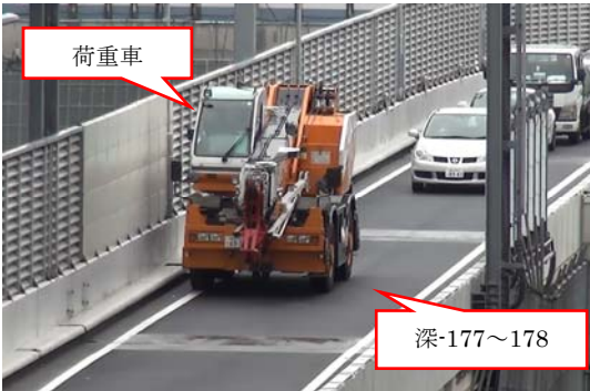
写真-1 床版載荷試験
