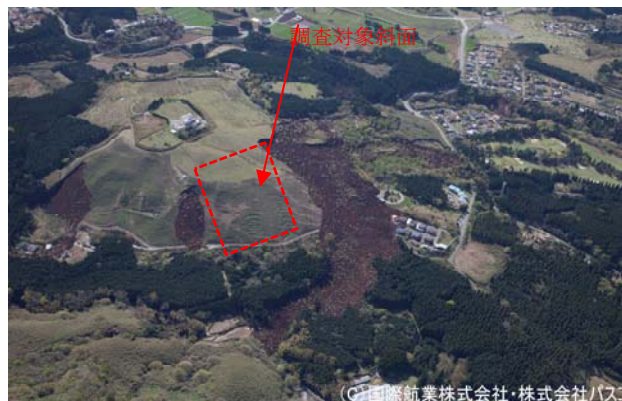
写真1：高尾野羽根溶岩ドーム斜面で発生した地すべり
