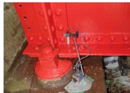
図-2 対象橋梁の支承部
