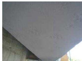
写真-2.2 下フランジ下面の腐食状況
