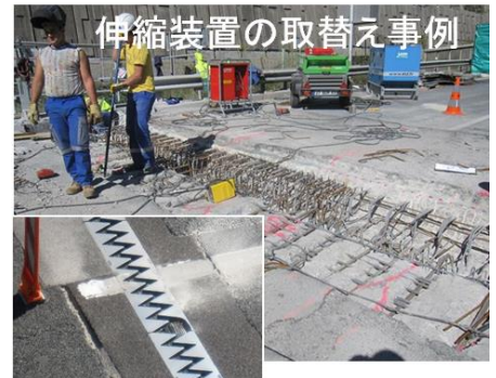
図1 欧州の伸縮装置の取替え工事
