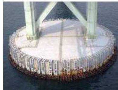
写真-1 明石海峡大橋 2P 主塔基礎
