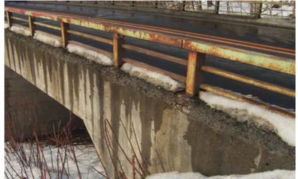
写真-1 凍害・塩害複合劣化を起こした橋梁<sup>1)</sup>
