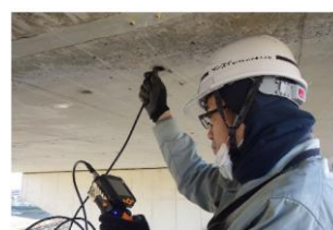
写真-2 CCD カメラによるボイド内部確認状況
