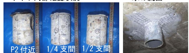
写真-4 コアとコア削孔部の後処理
